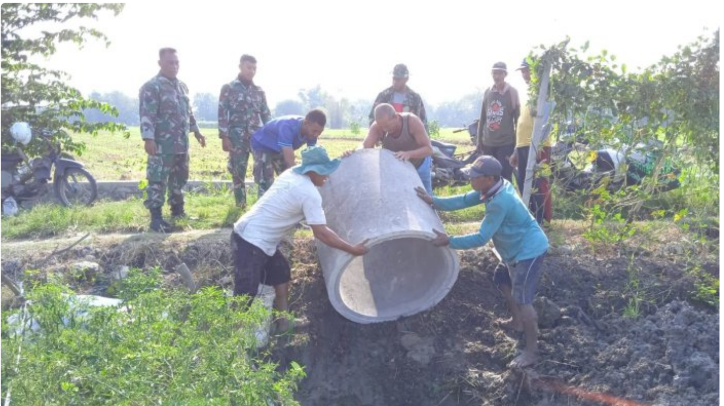
Satuan tugas (Satgas) TMMD Reguler Ke -117 Kodim 0717/Grobogan Mengerjakan Pembuatan Sumur Gali
